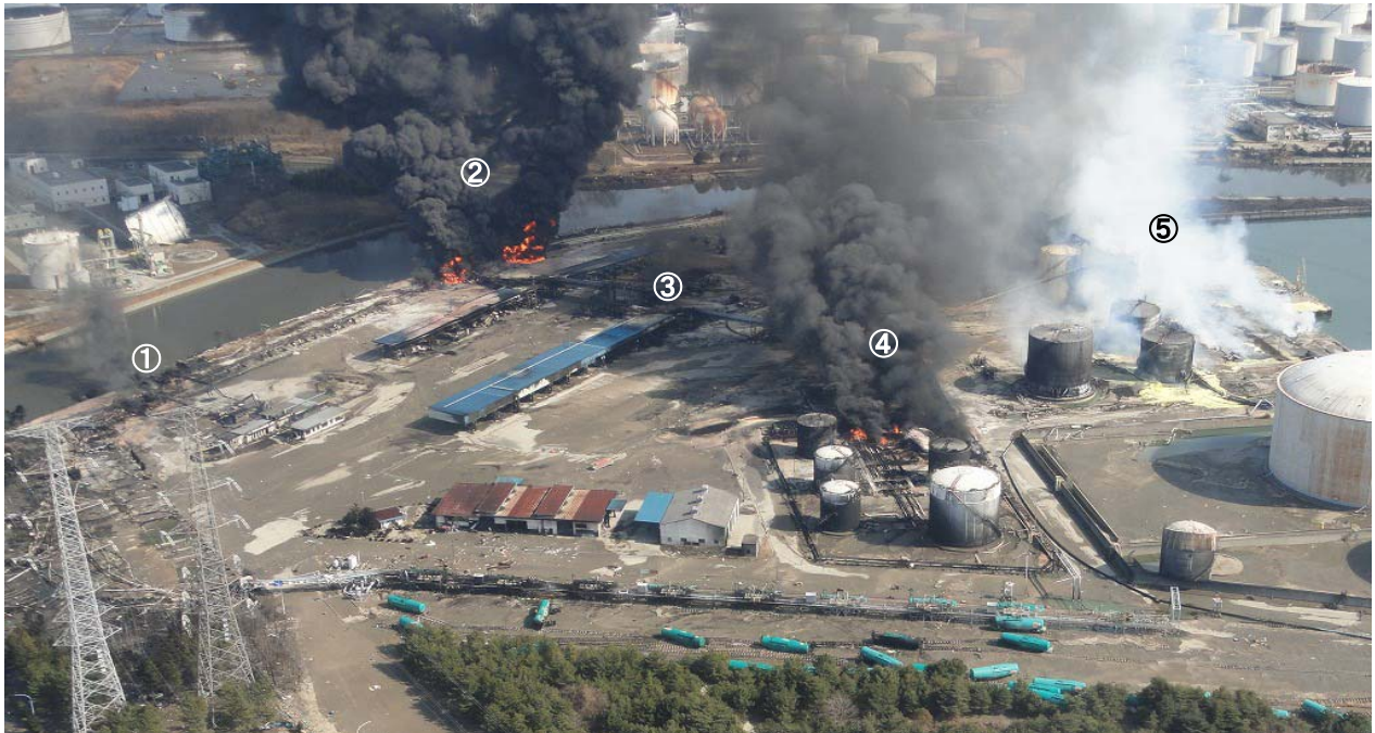
図 1 コンビナート火災の延焼状況（管轄消防本部提供）
