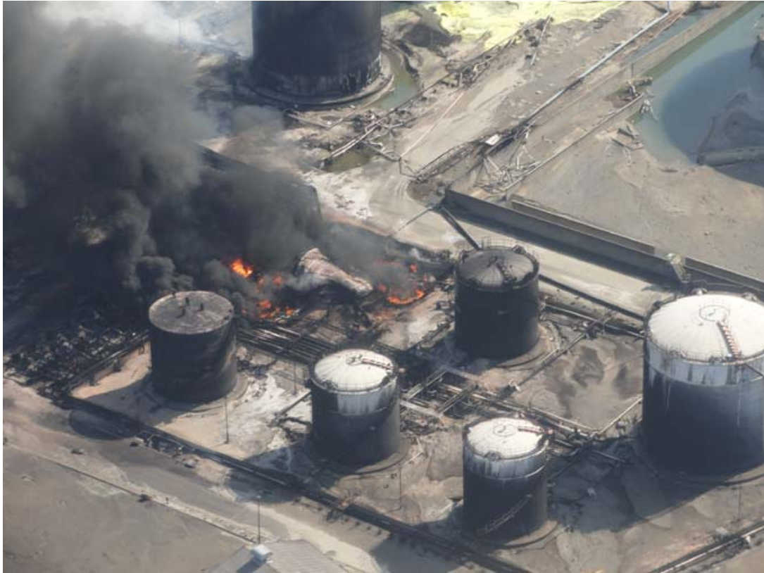
図4 火災時のガソリントankの状況
