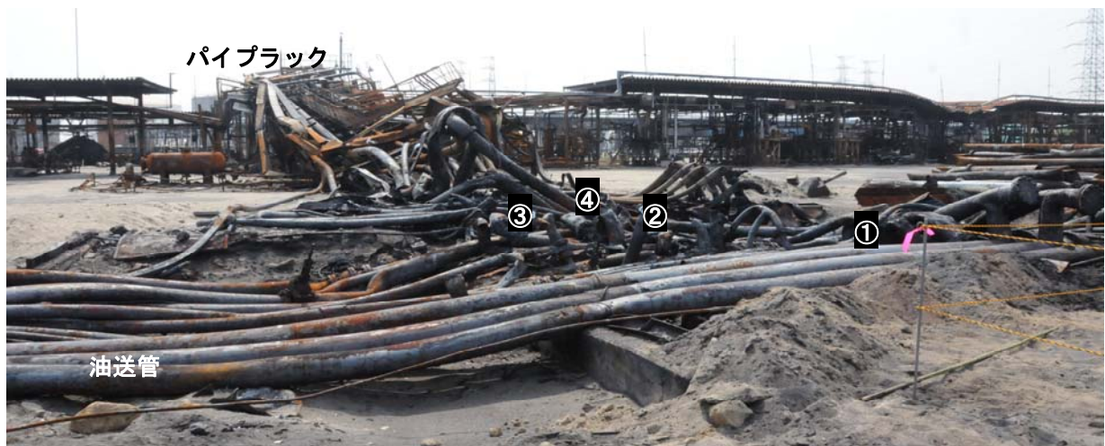
図7 油送管からパイプラックへ至る分岐部分の状況
