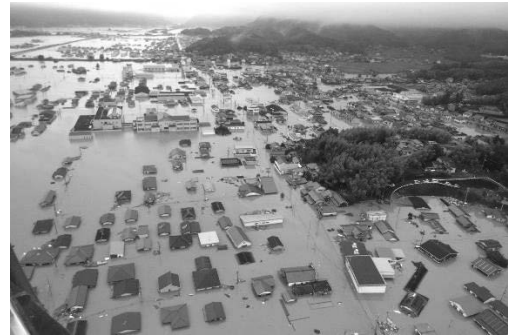
写真 1 倉敷市真備町箭田上空
