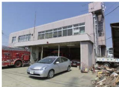
写真 4 石巻地区広域行政事務組合消防本部 石巻消防署渡波出張所
