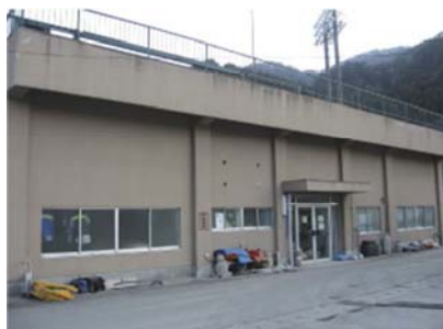
写真 5 釜石大槌地区行政事務組合消防本部 大槌消防署
