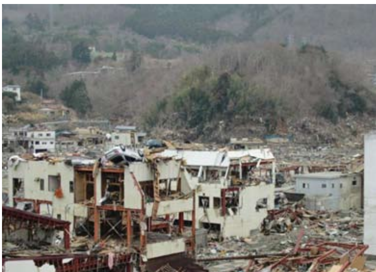
町中心部のRC建物
