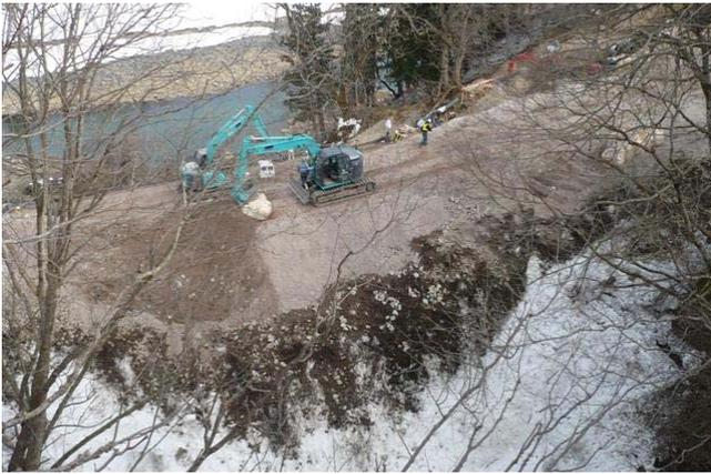
崩落した鉄道路床の復旧工事 (JR 飯山線横倉付近)
