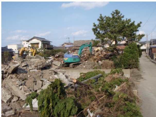
被害が大きかった地区では重機によるがれきの撤去作業が続いていた。
