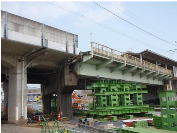
鹿島神宮駅付近の高架橋が損傷したため、修復工事が行われていた。
