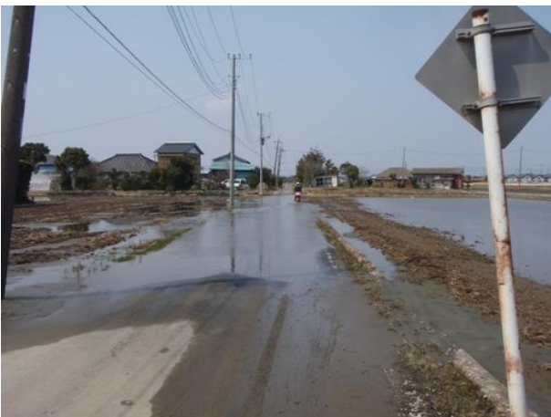
水田地帯を通る道路が液状化により水没しており、通行もままならない状態となっていた。
