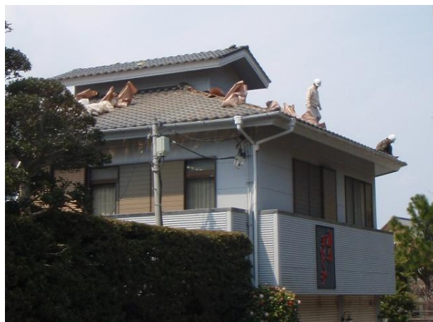
市内各所の住宅にて屋根瓦の修復作業が行われていた。
