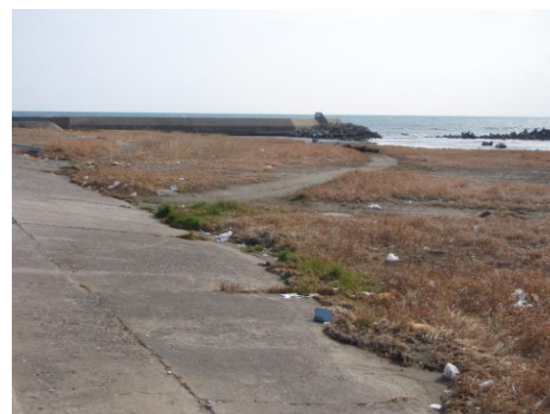
津波は海岸沿いに設けられた消波ブロックや防波堤を乗り越えて押し寄せた。
