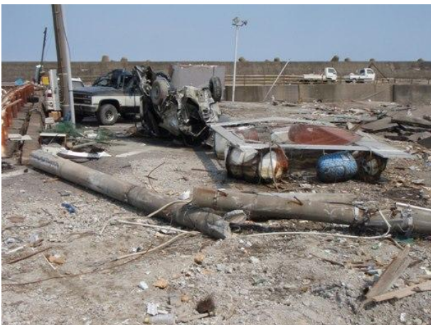
倒壊した電柱。撮影時には重機によるがれきの撤去作業が行われていた。
