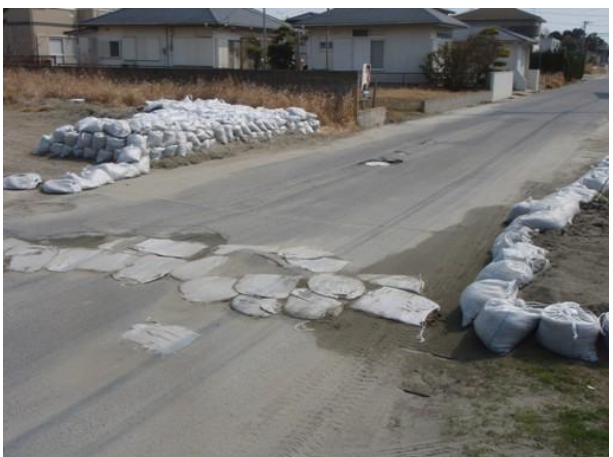
道路に亀裂が入ったため、応急処置が施されていた。道路脇には噴出した泥が道路に流れ込むのを防ぐための土嚢が積まれていた。
