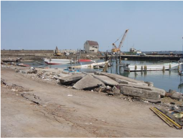
港湾部では被害を受けた船舶の引き揚げ作業が続いていた。奥の建物は大きく傾き、人が入れる状態ではなかった。
