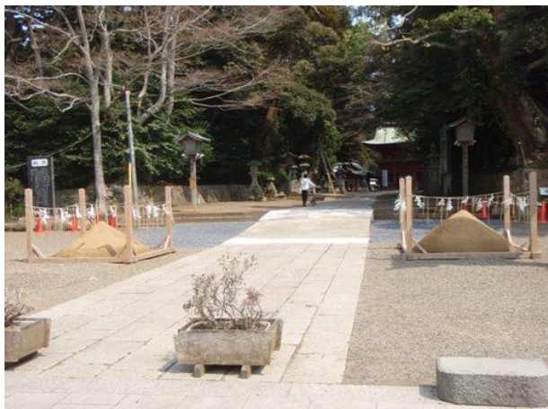
鹿島神宮では高さ 10 メートル、重さ 100 トンの大鳥居が倒壊した。鳥居があった地点には砂が盛られ、しめ縄が張られていた。
