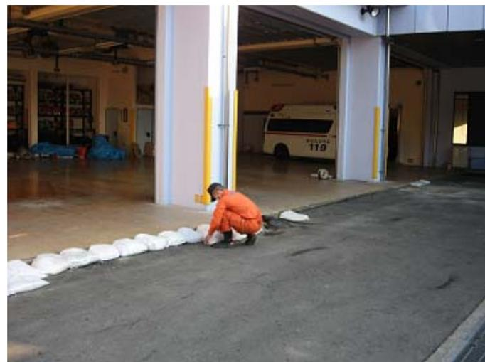
車庫と駐車場の間を土のうで埋めている様子(液状化により駐車場が地盤沈下したため)
