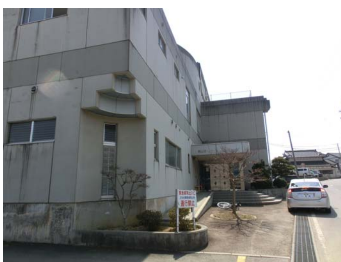
併設の防災センター側入口
