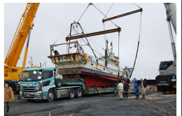
荒浜地区、打ち上げられた船を撤去する作業
