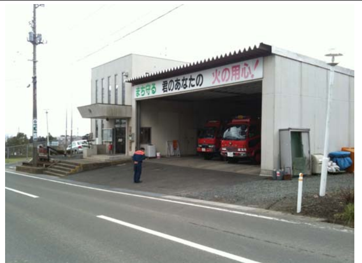
庁舎全景 庁舎は特に被害は見られない
