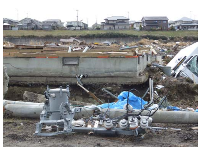
倒壊した電柱
