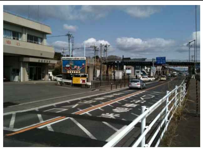
庁舎正面の道路 庁舎敷地と道路の間に水路がある
