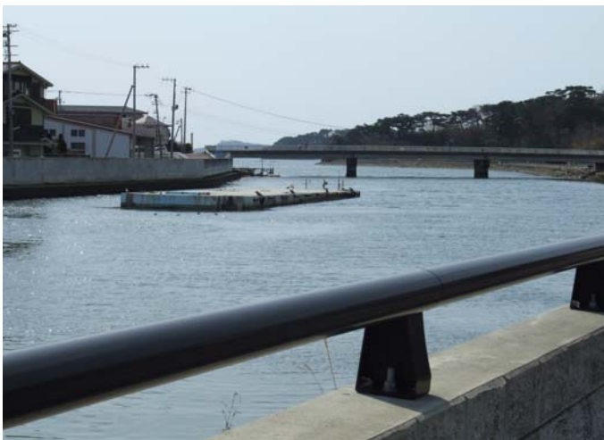
湾内から遡上し漂着した浮きドック 署前高城川
