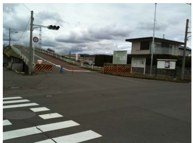
庁舎周辺道路 前方の橋は通行不能
