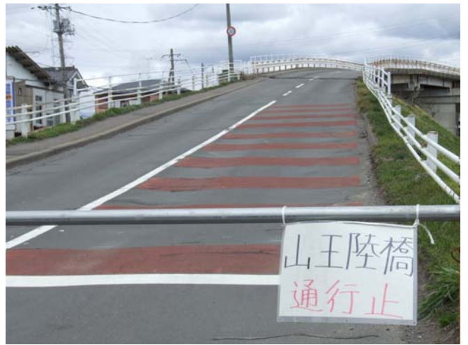
出張所付近の通行止めとなっていた陸橋
