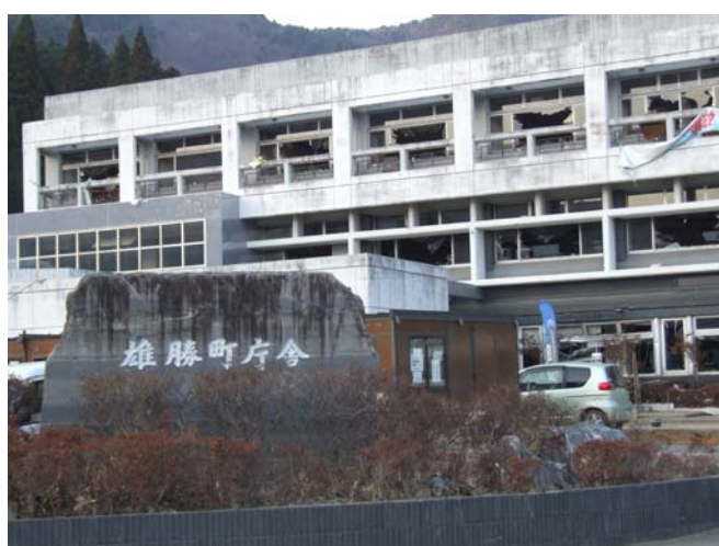
仮庁舎のある雄勝総合支所 3階まで波が入った
