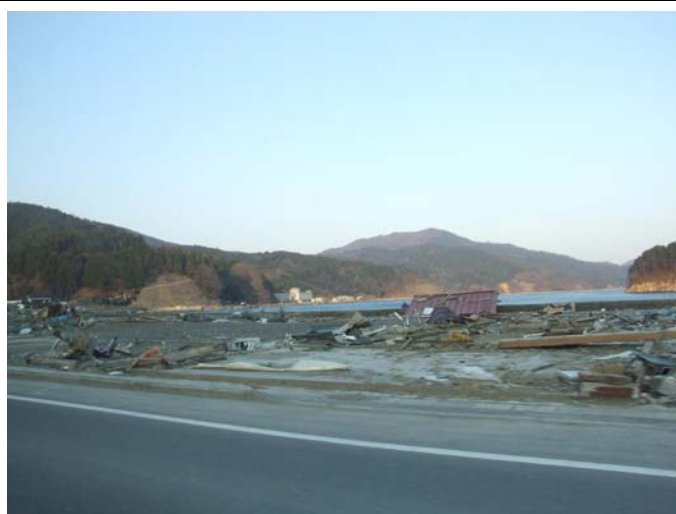
周辺の被害 残っている建物は見られない
