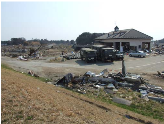
左手が鳴瀬川堤防法面 周辺では自衛隊が活動中
