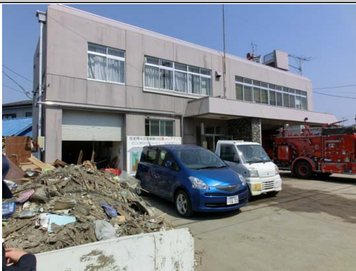
庁舎全景 (1) 周囲には瓦礫が多く残る
