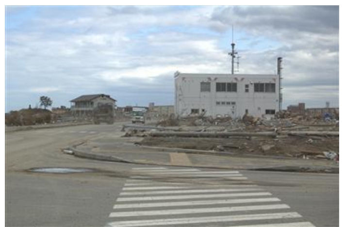
庁舎背面(陸側)から見た全景、周囲の建物は消失
