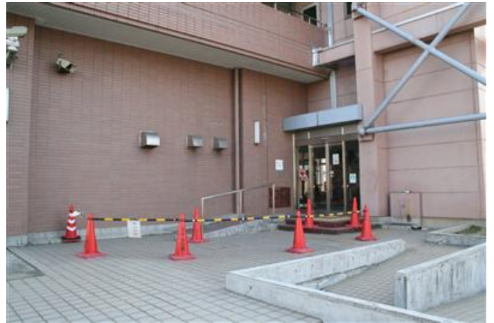
左写真の下部は立入禁止となっている。他に目立つ被害は見受けられず。消防署は活動中だった
