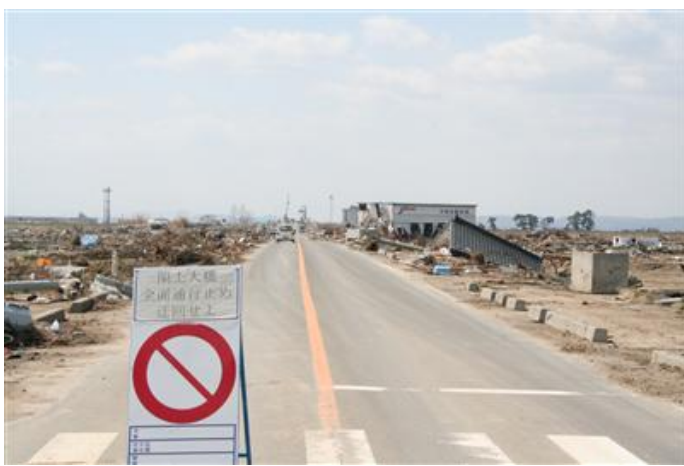
関上大橋仙台市側。この辺りも大きな被害が出た
