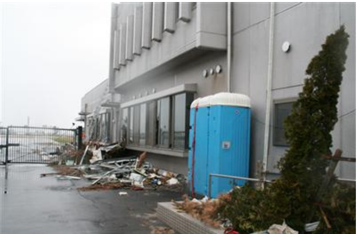
同分署は庁舎は残ったが、使用不能となった
