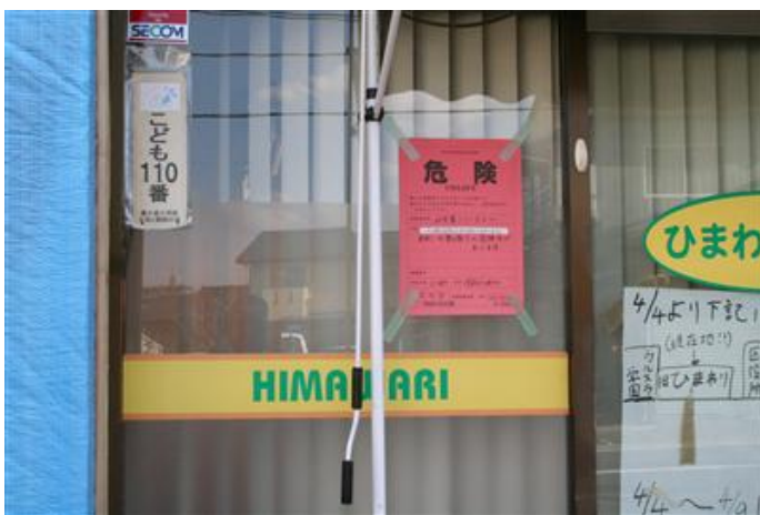
津波による被害がなかった内陸側でも地震による被害が見られた。区役所付近での応急危険度判定結果
