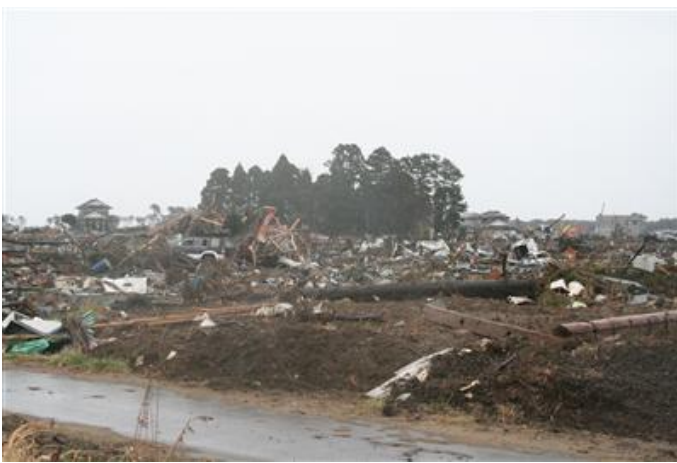
宮城野区の海側は津波により大きな被害を受けた
