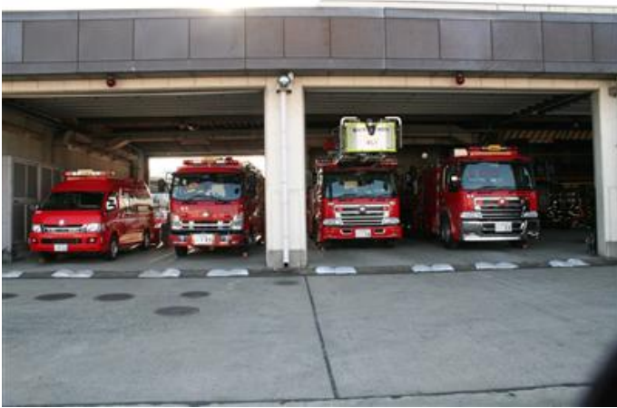
ガレージ手前に段差があり土嚢が置かれている
