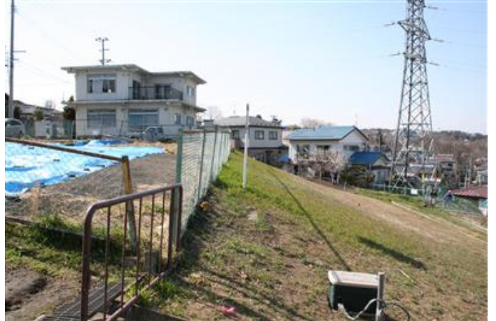
宅地に被災宅地危険度判定がされた。判定は赤(危険)
