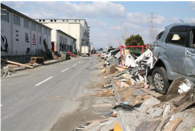
宮城野区仙台港は津波により被害を受けた
