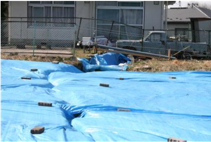
太白区緑ヶ丘では斜面上部に亀裂が見られた
