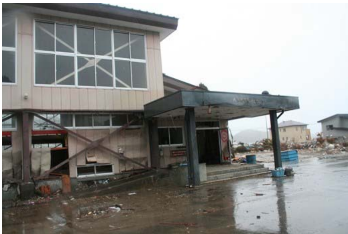
消防署付近の施設の被害（その1）
