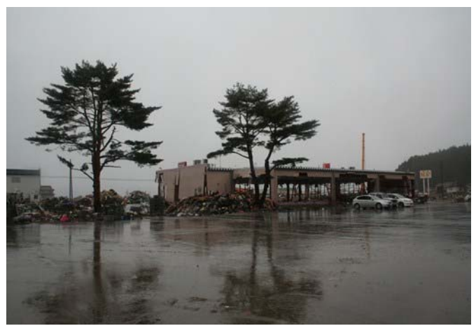
消防署付近の施設の被害（その2）
