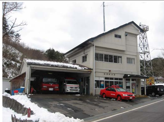
庁舎全景 特に被害は見られない
