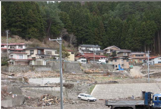
田野畑駅周辺の被害（庁舎からは離れている）
