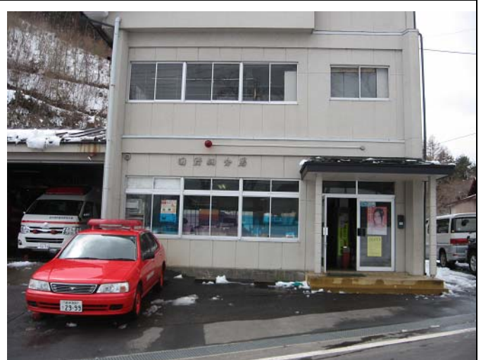
庁舎玄関付近
