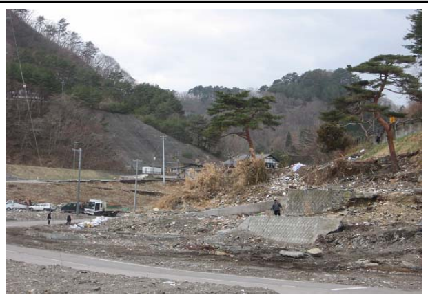
田野畑駅周辺の被害（庁舎からは離れている）
