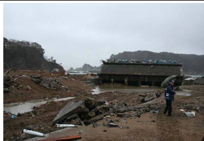
田老防潮堤・防波堤の被害
