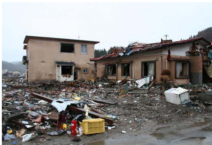
付近の建物の被害
