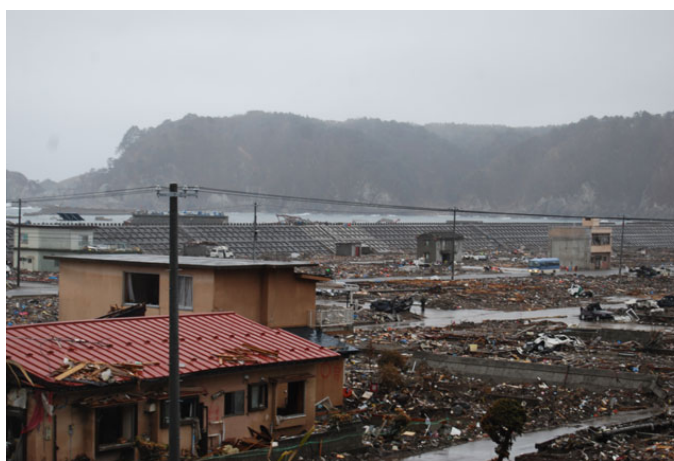
庁舎横の高台から見た防潮堤・防波堤
