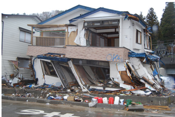
被害の大きかった防潮堤・防波堤付近の家屋
