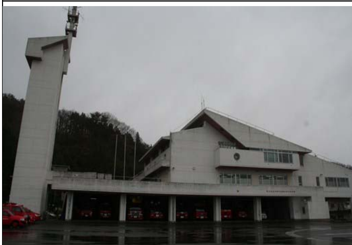
消防署の全景、被害は見受けられなかった
