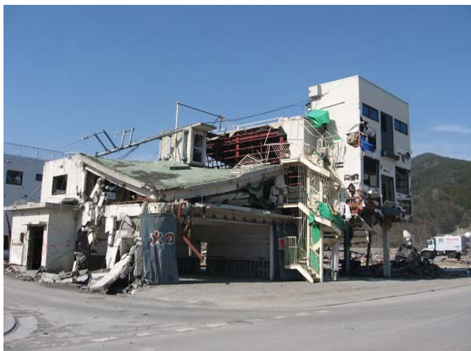
消防庁舎全景、車庫側から見る。使用されていない
