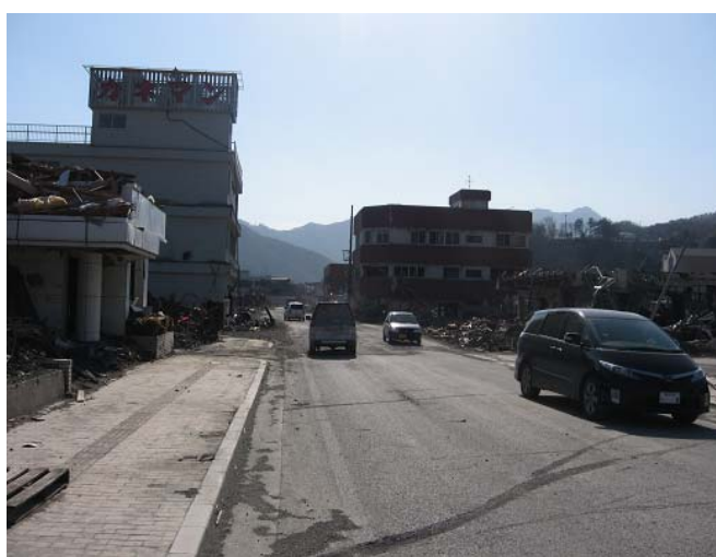
庁舎周辺、付近全体に津波被害があった
