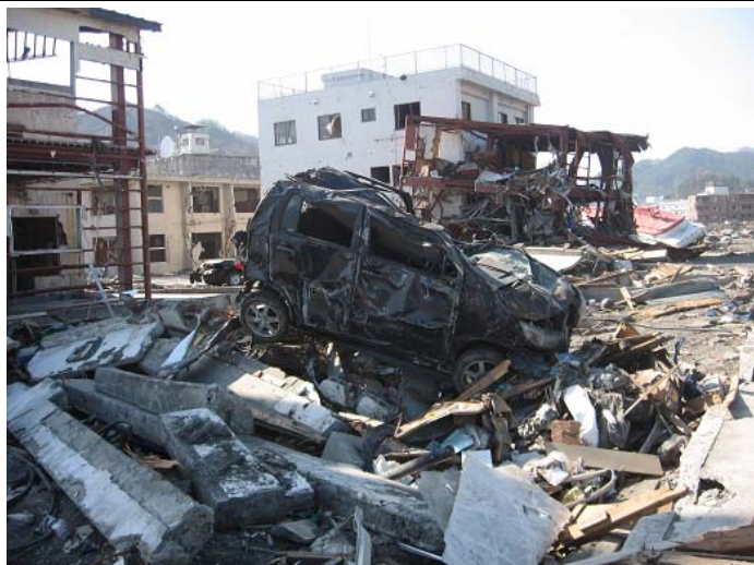
庁舎周辺の被害 車両も原型をとどめず
