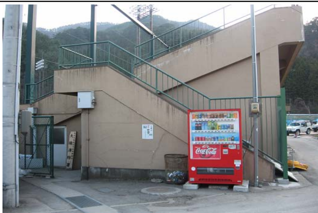
仮庁舎（野球場観覧席下の一部）
