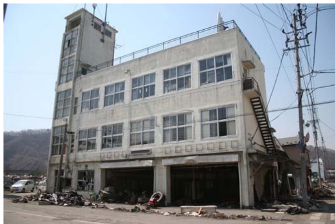
消防本部の正面玄関、一階部分は水没した模様
