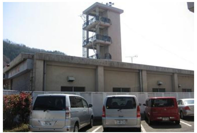
消防署仮庁舎の裏面
