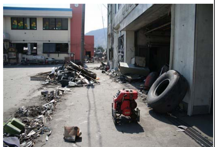
庁舎の玄関前、中央は可搬ポンプ
