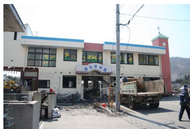
消防本部の付近にある保育園の被害様子
