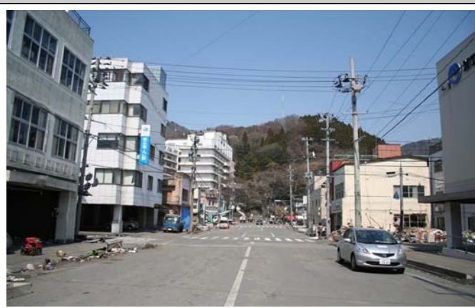
消防本部前の道路（左側は本部庁舎）
