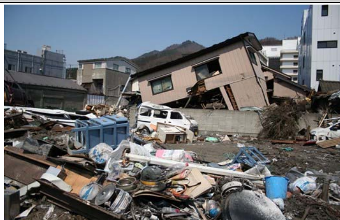
消防本部庁舎裏の被害
