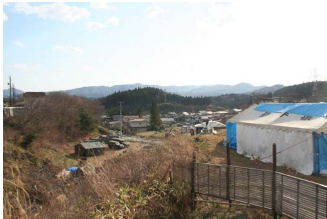
仮庁舎の南面
