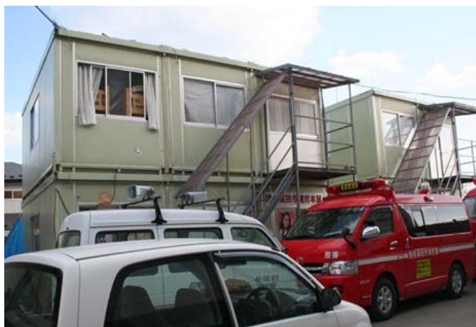
消防本部の仮庁舎（その1）
