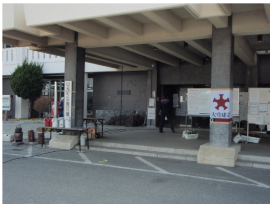
庁舎玄関（外観の被害はみられなかった）
