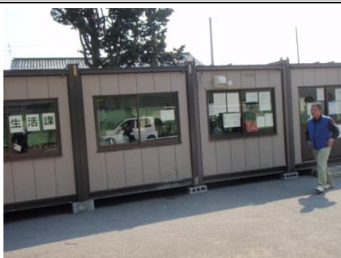
各課の執務室が設けられたプレハブの庁舎
