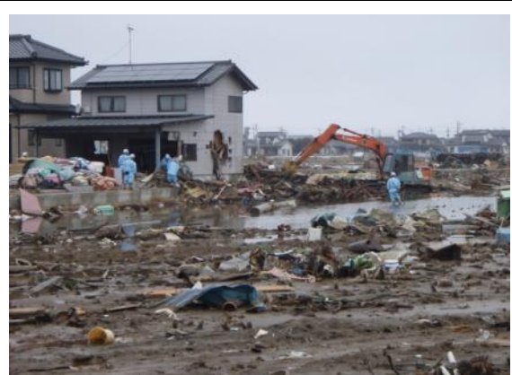
被害状況の写真 2
