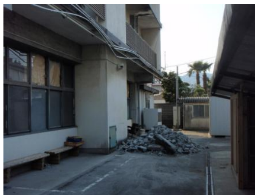
本庁舎の被害の様子
