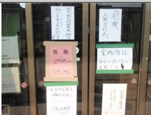
本庁舎は応急危険度判定で「危険」と判定された
