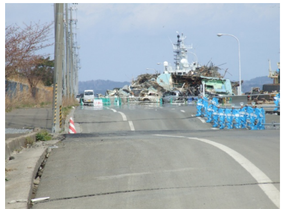
塩竈市魚市場付近の被害の様子 (湾曲した道路と打ち上げられた船)
