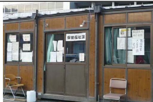
仮設の支所庁舎
