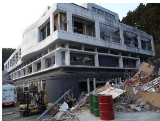
雄勝総合支所（旧雄勝町役場庁舎）
