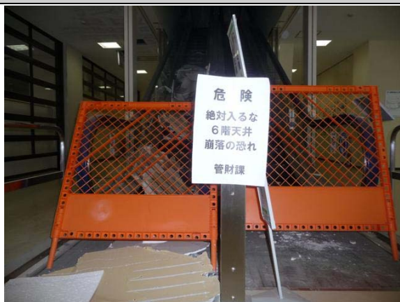
市役所1階エスカレータ付近
