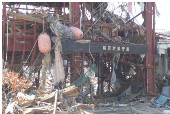
屋上まで津波に襲われた防災対策庁舎
