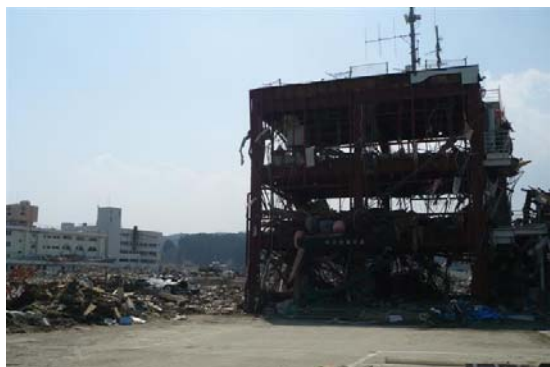
防災対策庁舎（左手に本庁舎はあった）
