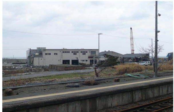
陸中八木駅付近
