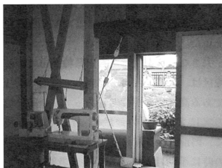
耐震補強をした住宅（東京墨田区）
