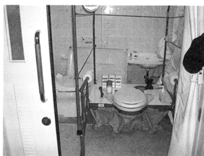
要援護者用の洋式の仮設トイレ (能登半島地震)
