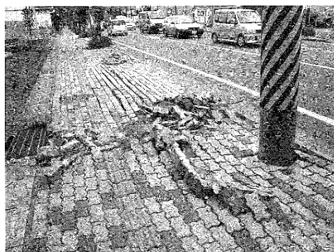
写真⑦ 柏崎市 中心市街地 道路の破損
