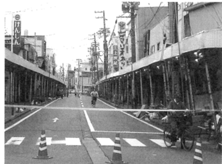
商店街の被災状況（柏崎市内）
