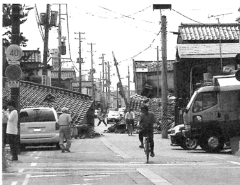
住宅の倒壊による道路閉鎖状況
