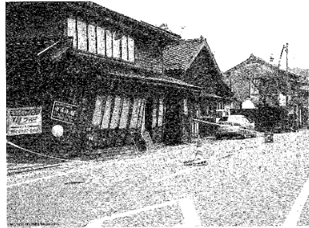
住宅の被災状況（輪島市門前地区）
