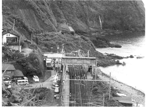
JR信越線青海川駅付近の土砂崩れ
