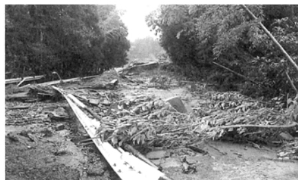
水が引いた直後の道路
