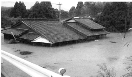
軒下まで冠水した人家
