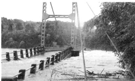
崩壊・流出前の川内川に架かる久住橋
