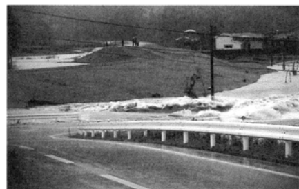
決壊した堤防から濁流が流れ込む
