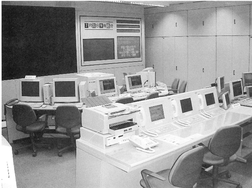
防災情報センター（消防局）
