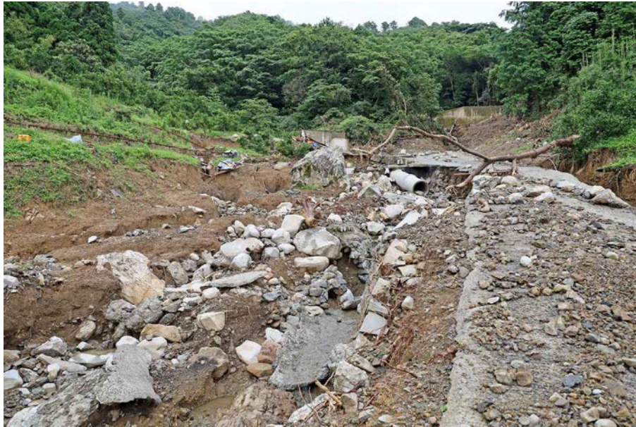
図6 芦北町女島地区天見岳の治山堰堤（写真右奥）下流部での土石流による侵食状況。
