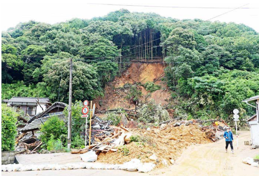
図5 芦北町女島小崎地区の斜面崩壊と住宅被害。
