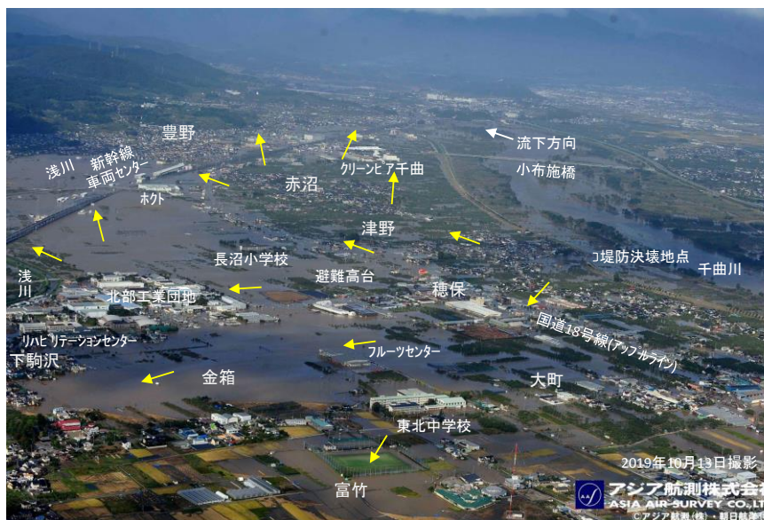
写真1 千曲川中流左岸の穂保地区における堤防の決壊と堤内地への浸水状況（アジア航測株式会社（2019）に筆者が加筆）
