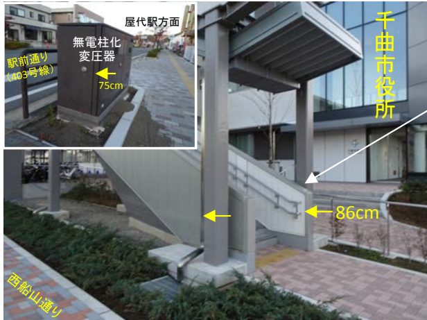
写真3 千曲市役所前の連絡橋における浸水痕跡 (2019年11月19日撮影)
