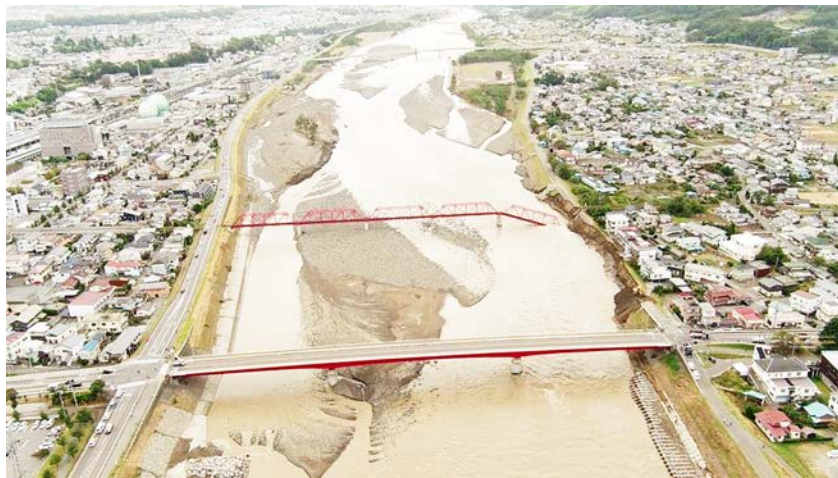
写真4 諏訪形（上田市）の堤防欠損：国土交通省北陸地方整備局
