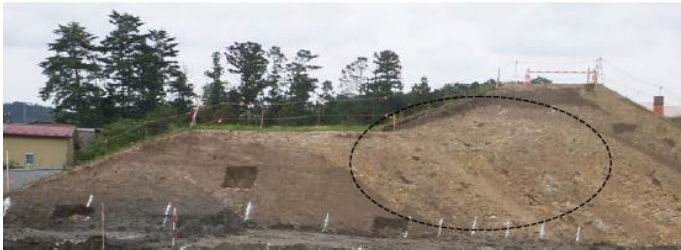
天端からの撒き出しによって形成されたと考えられる斜めの構造
