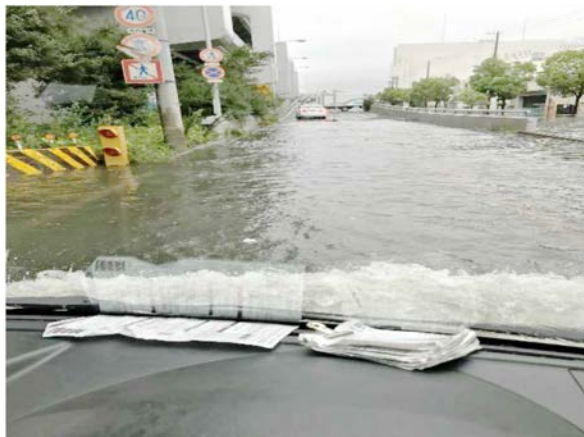
図5 六甲大橋入口の浸水状況 (Twitterより 9/4(火) 14:23配信)
