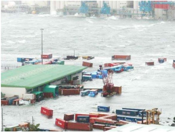
図4 六甲アイランドでの浸水被害状況 (毎日新聞、9/4 14:15、湯谷茂樹撮影)
