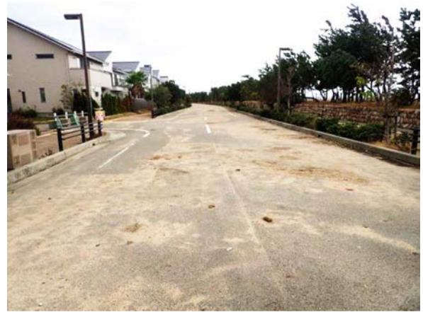
図3 芦屋市涼風町における越波浸水痕跡
