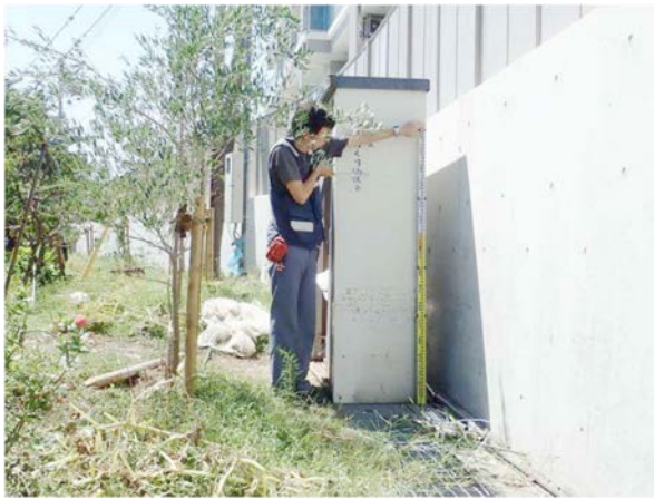
図11 サンシャインワフ神戸の北側の防潮堤における浸水痕跡
