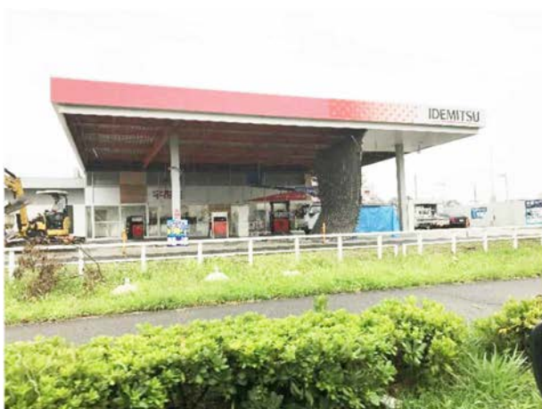
写真4 店舗屋根裏材の剥離・脱落（左：大阪府堺市、右：大阪府貝塚市、いずれも著者撮影）
