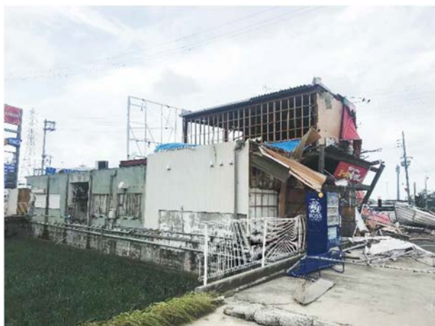
写真1 強風により壁や屋根が飛散した店舗建物(大阪府泉南郡田尻町、著者撮影)
