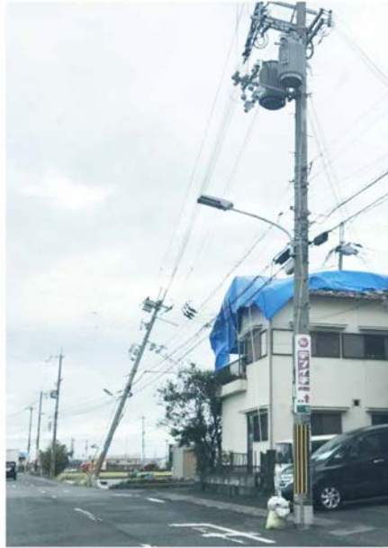
写真7 折損・倒壊した電柱（左：大阪府泉南市、産経新聞社産経フォト 9) 、右：大阪府泉南市、著者撮影）
