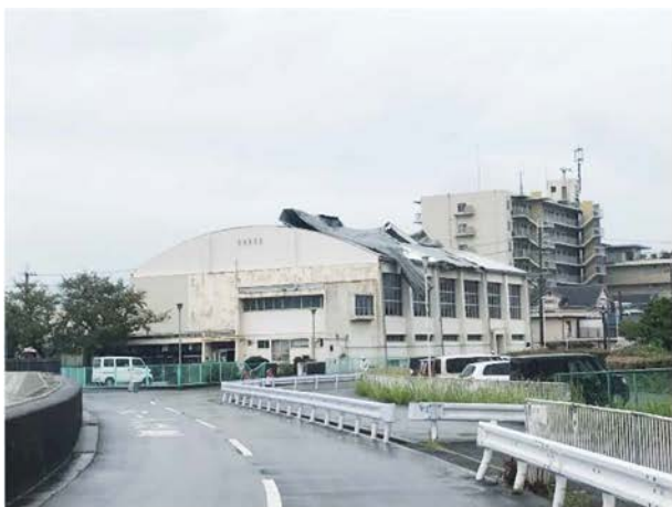
写真3 強風により屋根が飛散した体育館（大阪府岸和田市、著者撮影）
