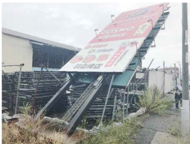
写真6 強風により倒壊した広告板（左：大阪府泉南郡田尻町、右：大阪府泉南市、いずれも著者撮影）
