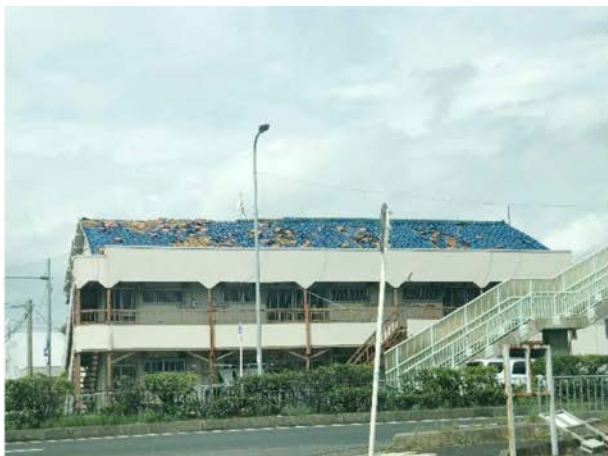
写真2 屋根瓦の剥離・飛散被害（いずれも大阪府泉佐野市、著者撮影）
