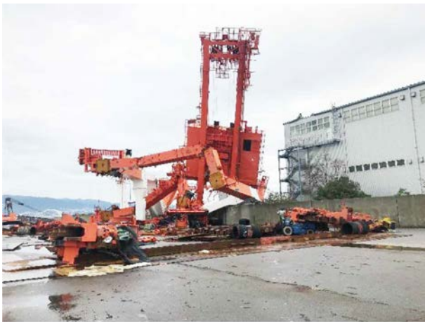
写真8 強風により転倒、破壊されたガントリークレーン（兵庫県西宮市、著者撮影）
