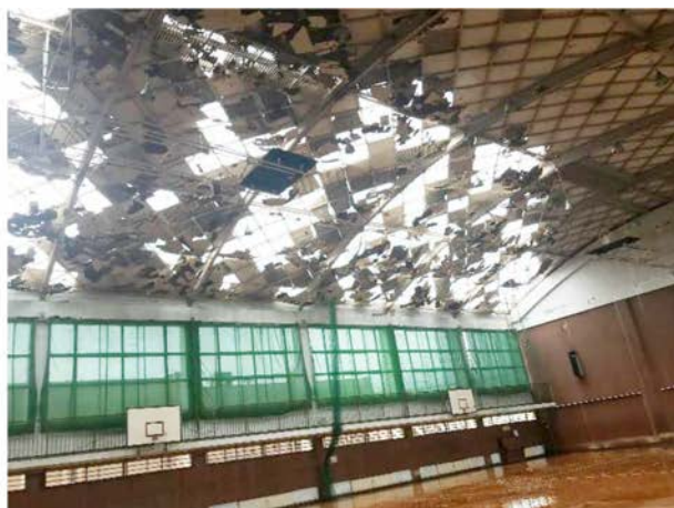
写真3 強風により屋根が飛散した体育館（大阪府岸和田市、著者撮影）
