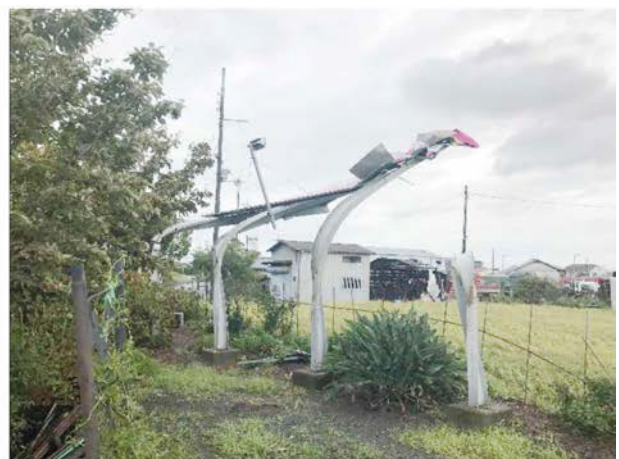
写真6 強風により倒壊した広告板（左：大阪府泉南郡田尻町、右：大阪府泉南市、いずれも著者撮影）
