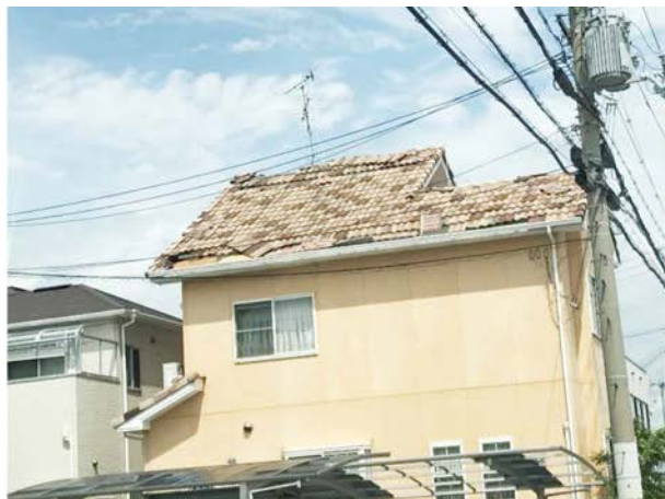
写真2 屋根瓦の剥離・飛散被害（いずれも大阪府泉佐野市、著者撮影）
