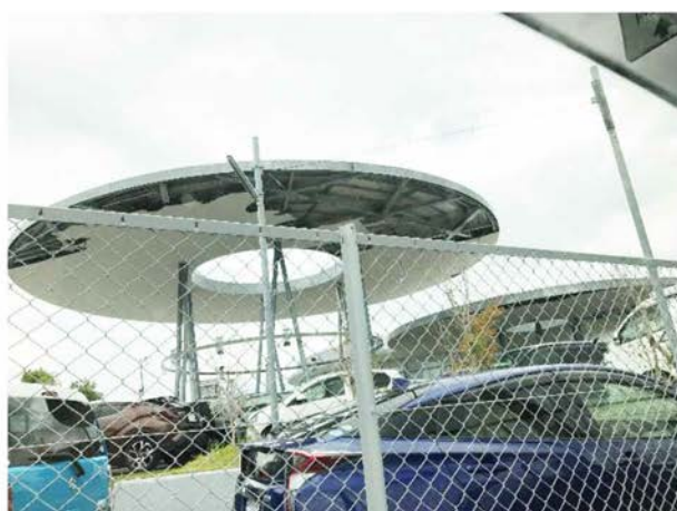
写真4 店舗屋根裏材の剥離・脱落（左：大阪府堺市、右：大阪府貝塚市、いずれも著者撮影）
