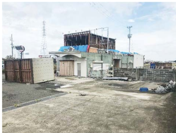
写真1 強風により壁や屋根が飛散した店舗建物(大阪府泉南郡田尻町、著者撮影)
