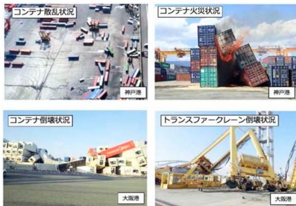
図-5 港湾の被害状況 2)
