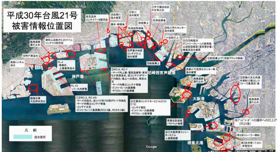
図-4 台風21号による浸水および被害の状況 2)
