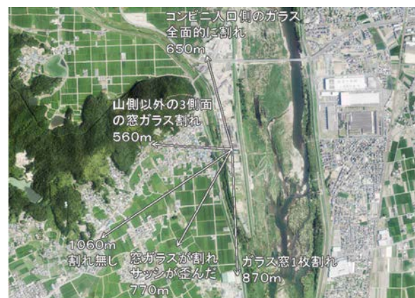
図5 爆風による窓ガラスの被害状況 2), 3)
