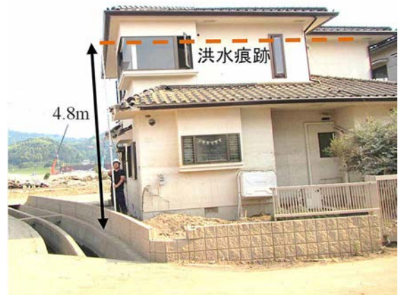
図-4 浸水深4.8mの状況
