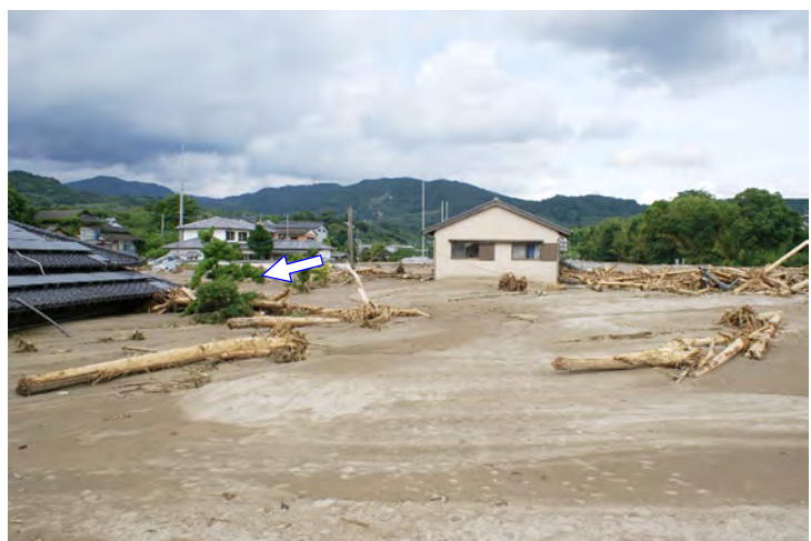
写真2 北川本陣橋上流での被災状況 [2017/7/8撮影]
