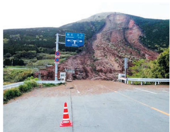
図-13 4月16日の地震後の阿蘇大橋跡と大規模斜面崩壊
