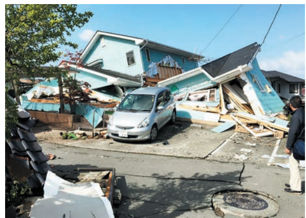
図-8 4月16日の地震後の益城町の被害 (新耐震の住宅も被災)
