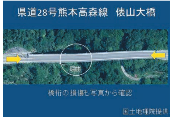
図-16 4月16日の地震後の屈曲した俵山大橋
