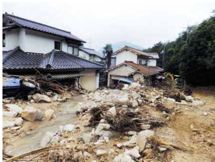
図-3 1階部分に壊滅的なダメージを被った家々 （広島市安佐北区可部東6丁目、この付近の道路勾配は約4° 2014年8月26日撮影）
