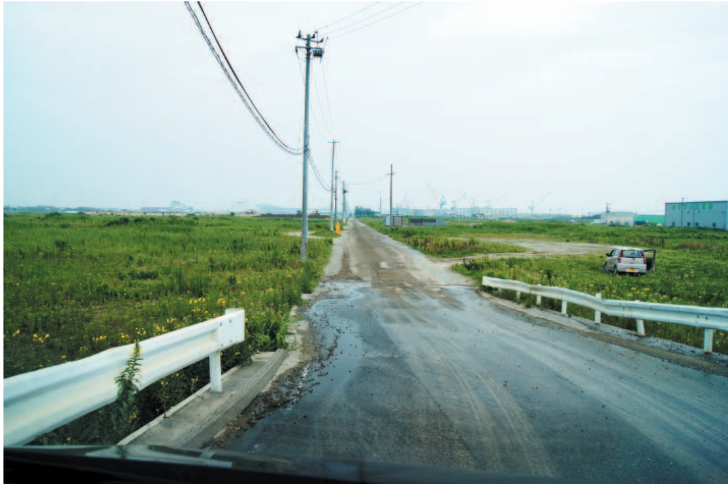
写真 1 : 移転元地の現況 (東松島市大曲地区)
